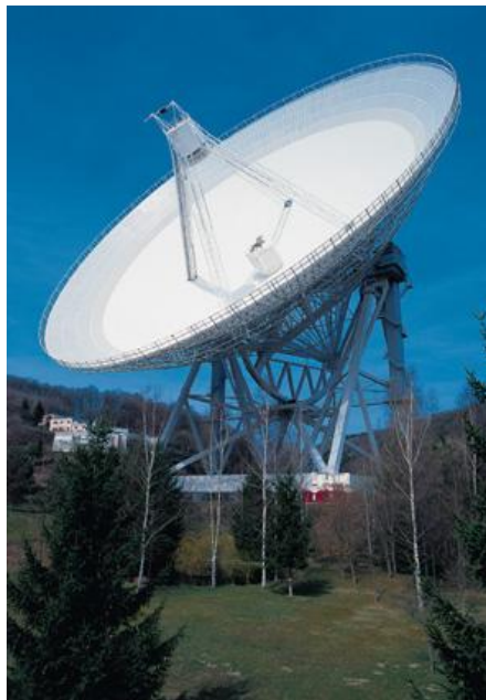
Bild 2: Radio-Teleskop Effelsberg/Deutschland, Durchmesser 100m Foto: Max-Planck-Institut für Radioastronomie, Bad Münstereifel-Effelsberg
