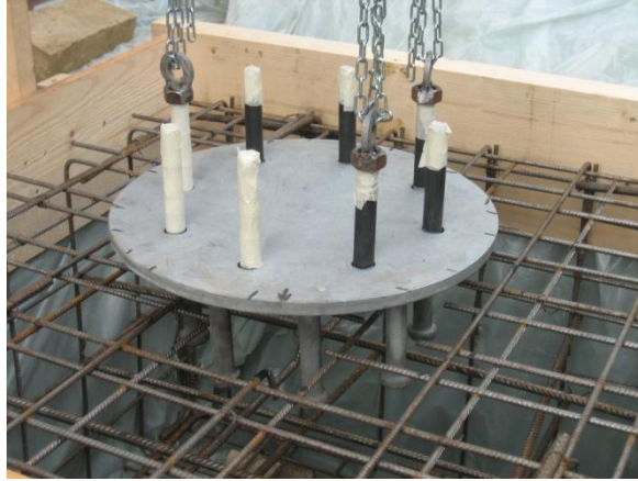
Bild 9: Fundament-Bewehrung mit ausgerichteter Fußplatte für den Mast
